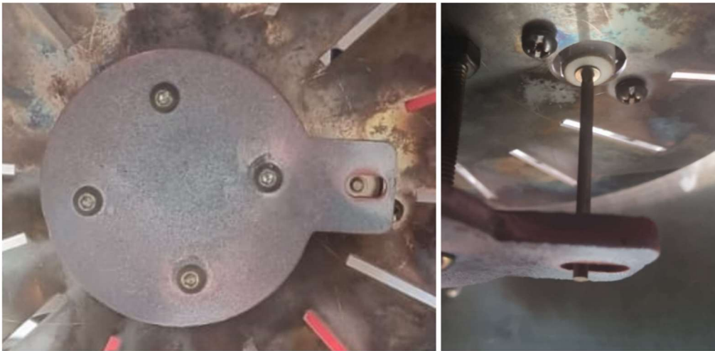
Ilustración 2: Correcto posicionamiento de varilla de ignición/detección de llama.
